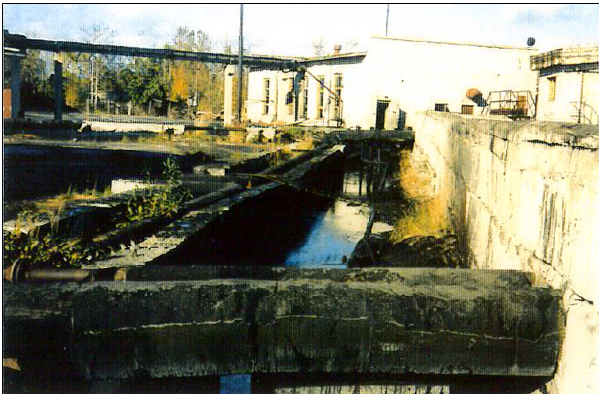
Foto 6. Praeguseks likvideeritud masuudi katlamaja edastamise süsteem (foto Maves AS ja Golder Associates AB 1996. a. uuringuaruandest).
